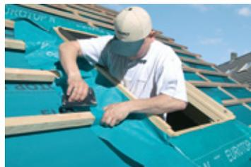
Универсальная система монтажа **FAKRO**: окна могут быть установлены как на стропилах, так и на обрешетке. Широкая региональная сеть технической поддержки и сервис-центров позволяет проводить бесплатную сертификацию монтажных бригад, осуществлять выезд на строительные объекты и предоставлять бесплатные консультации.
